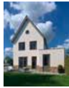
Achtergevel F1 en F2
