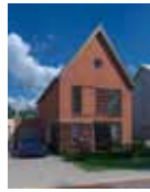
Voorgevel F1 en F2
