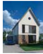
Voorgevel F1 en F2
